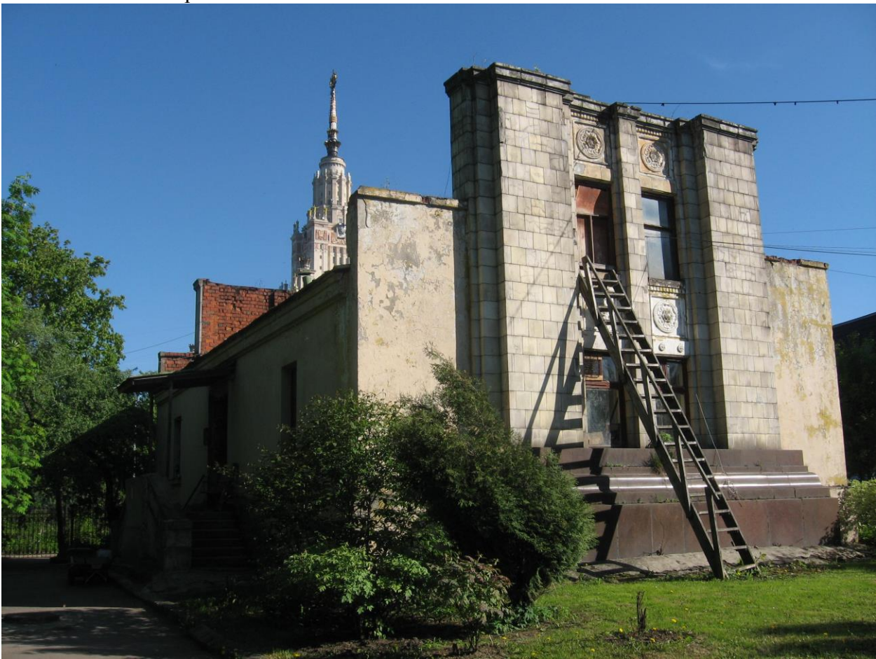
Рис. 86. Здание дендрария (макет студенческого общежития) очень давно нуждается в ремонте. В 2011 г. ректор В.А.Садовничий выделил средства на ремонт, который начался в декабре 2011 г.
